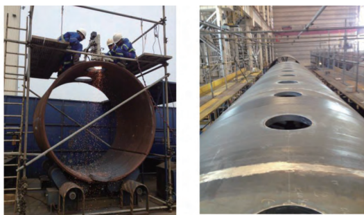
图 8 孔位切割评定及现场施工
