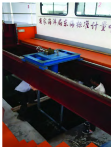
图 5 东海标准计量中心水槽安装现场图
